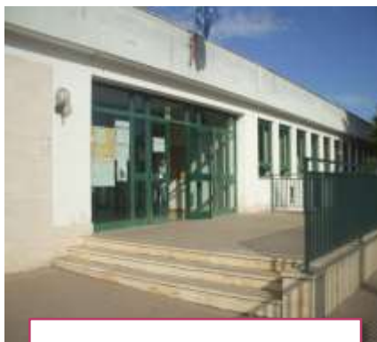
1. Ingresso del plesso Rione Diaz (Cartiera)
